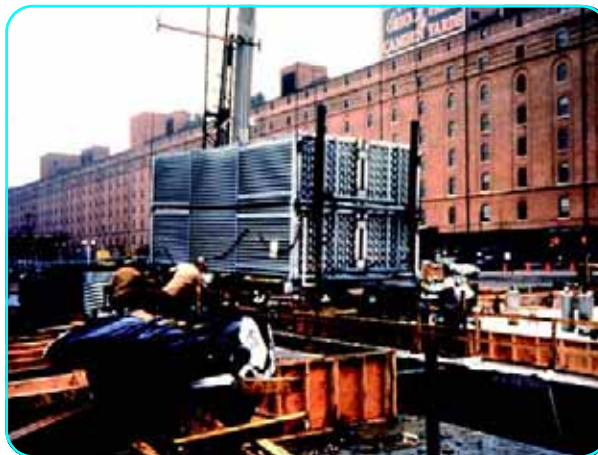
Im Betontank installierte Rohrbündel
