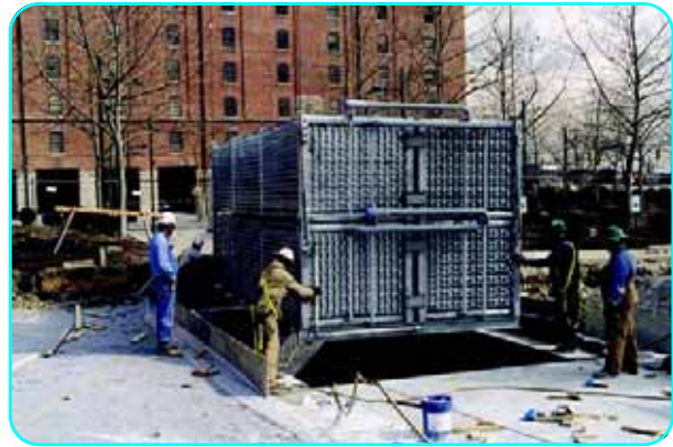
Installation eines Rohrbündelmoduls
