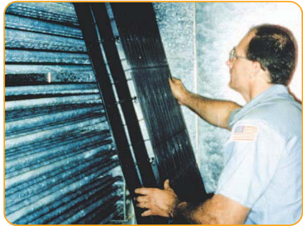
Abnehmbare Tropfenabscheider für Zugang zur Glattrohrschlange
