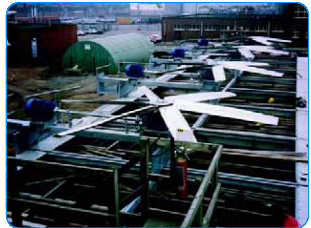
Mechanisches Antriebssystem montieren
