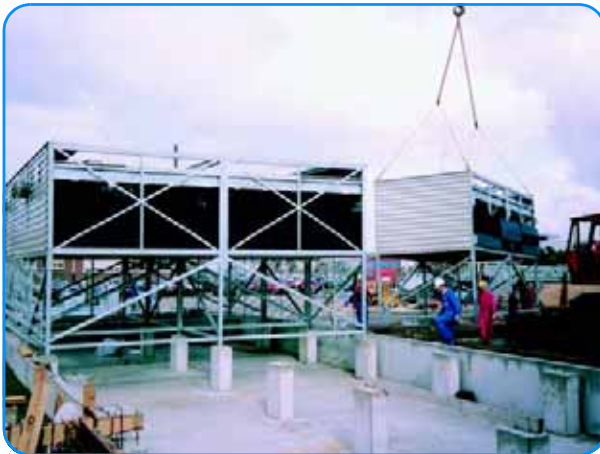
Wärmeübertragungsmodule vom LKW in das Betonbecken heben
