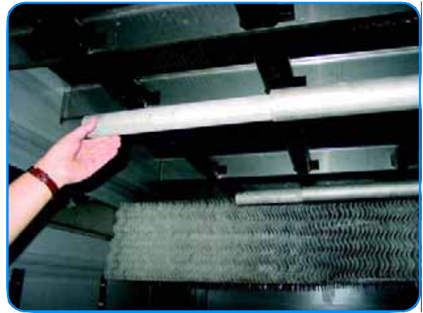
Teleskop Füllkörperträger (nur für den 26-mm-Schwerbetriebsfüllkörper)
