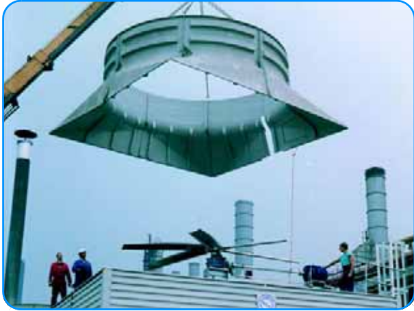
Lüfterzylinder und Plenumteile montieren und positionieren
